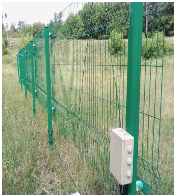
Рисунок 119 – Пример установки извещателя «Рубеж» на металлическом ограждении
